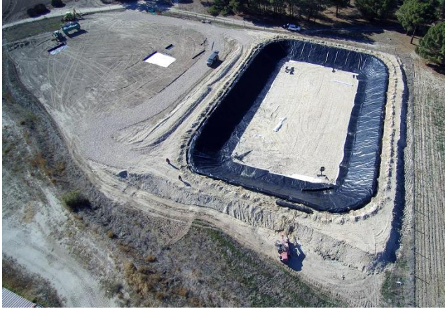
Obras de realización de balsa de almacenamiento de purines
