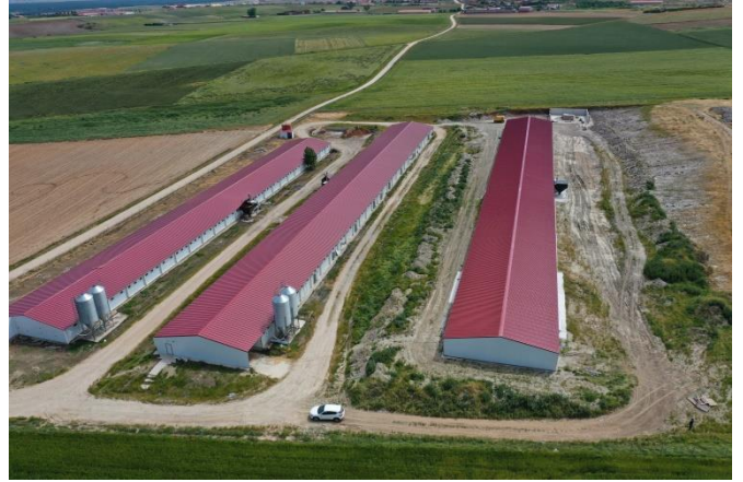
Obras de ampliación de Explotación de pollos de engorde
