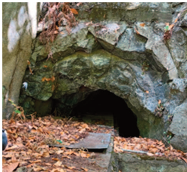
Comienzo del canal en túnel
