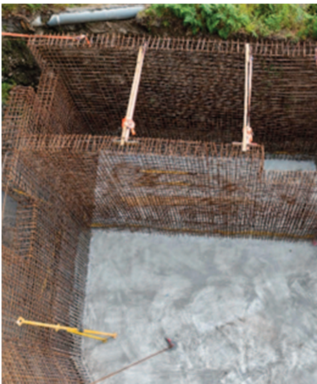
Depósito y su arenero, actualmente en ejecución
